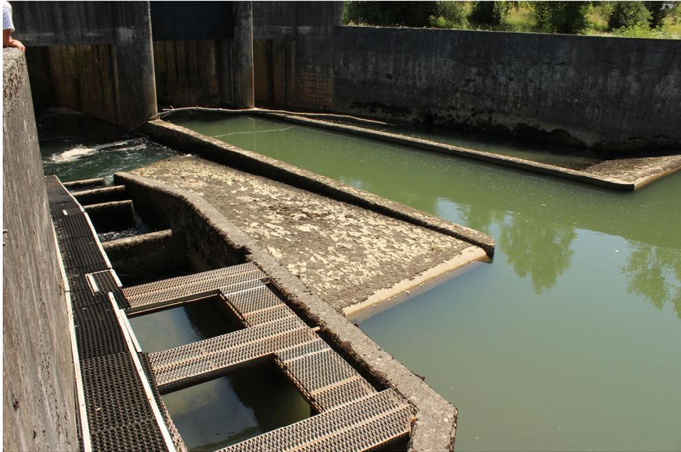
Figure 7. Vue amont du siphon avec la passe à poissons et la rampe de sauvetage à castor (ACME 2024)
