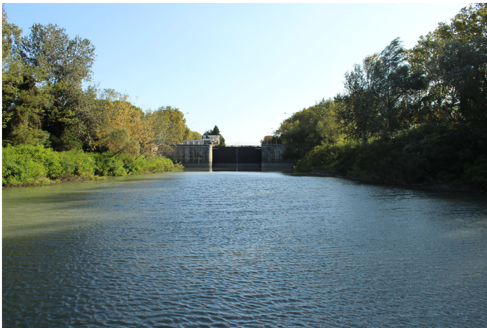
Figure 8. Vue vers l'aval de l'embouquement de l'écluse d'Arles (ACME 2024)
