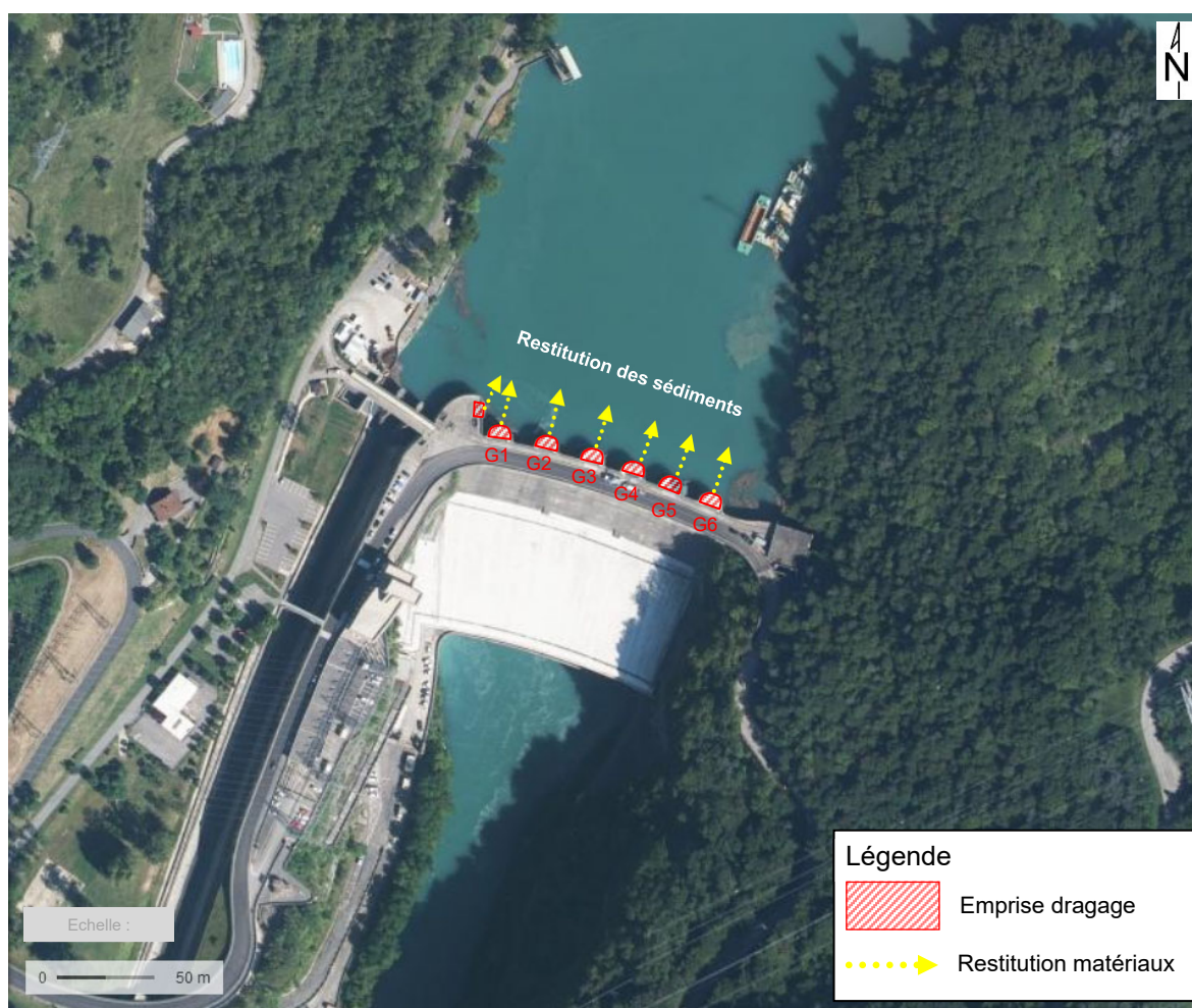
Figure 2. Localisation des travaux (© Géoportail 2023)
