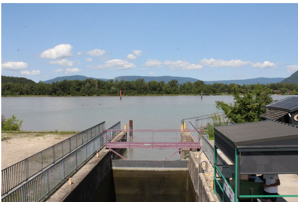
Figure 7. Vue de la zone d'intervention dans l'axe de l'écluse. ACME 2024
