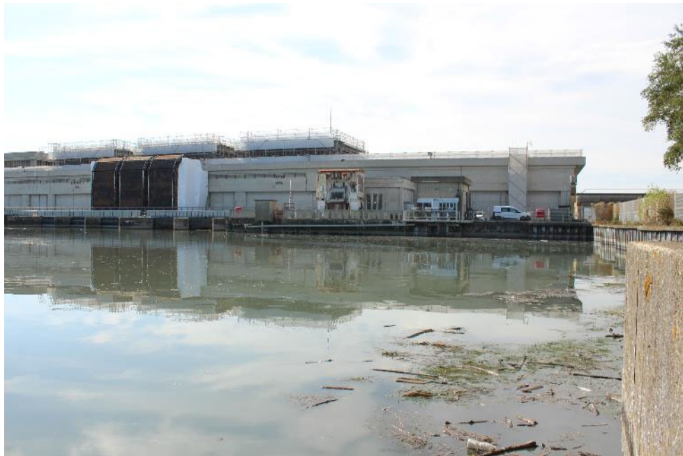
Figure 7. Préfiltration usine de Bollène - (ACME -2024)
