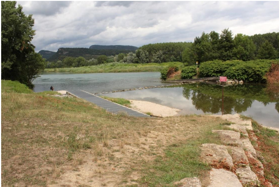
Figure 6. Vue sur la zone d'intervention (ACME, 2023)
