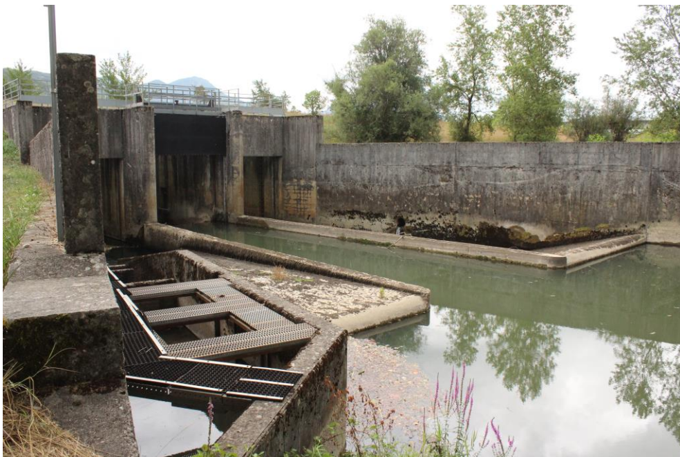
Figure 6. Vue amont du siphon avec passe à poissons et rampe de sauvetage à castor (ACME 2023)
