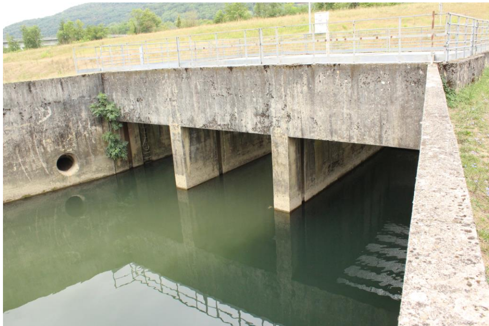
Figure 7. Vue aval du siphon (ACME 2023)
