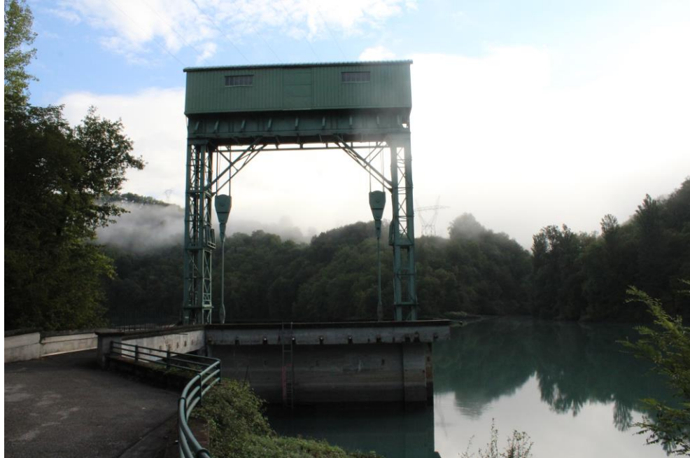
Figure 6. Vue sur la zone d'intervention au niveau de l'ouvrage de gestion de la vanne de fond (ACME, 2022)
