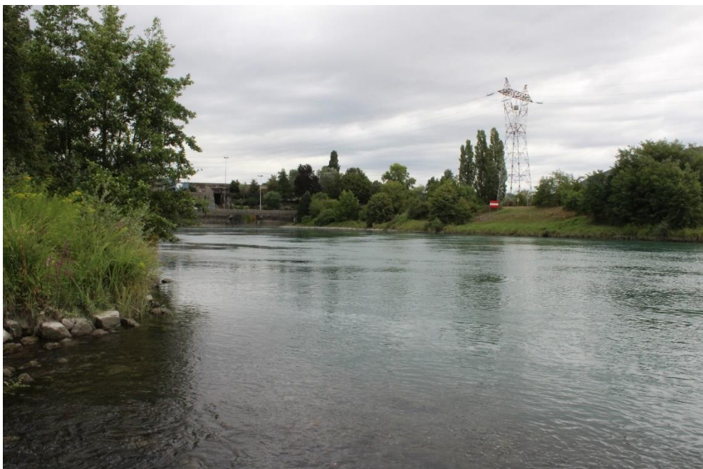
Figure 8. Vue sur le canal de fuite en aval de l'usine de Brens (ACME, 2023)
