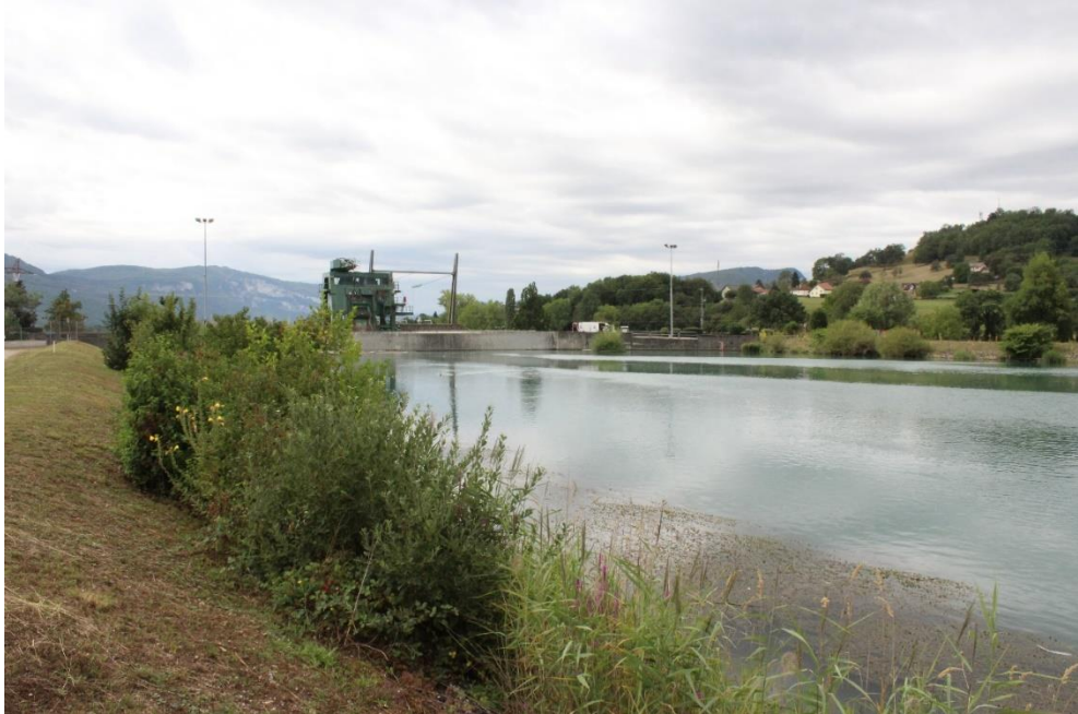
Figure 7. Vue sur la zone d'intervention en amont de l'usine de Brens (ACME, 2023)
