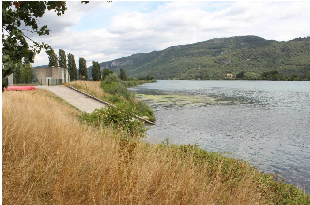
Figure 9. Vue sur la rampe à bateaux de Peyrieu en rive droite du Rhône (ACME, 2023)
