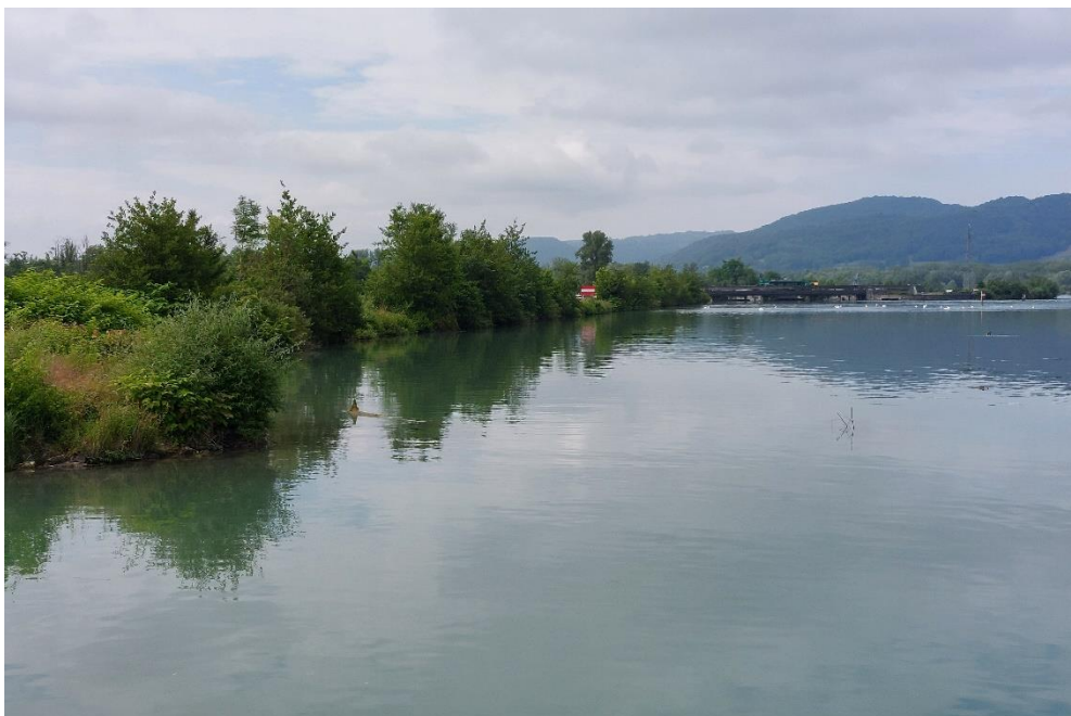
Figure 10. Berge rive gauche en aval de l'écluse de Savières. CNR 2024
