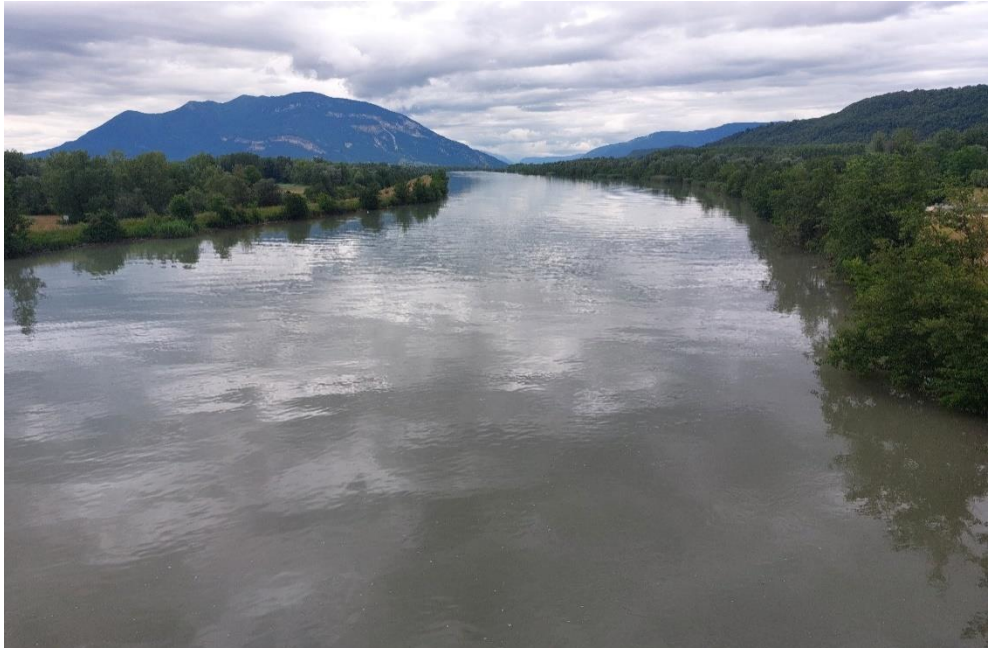
Figure 11. Canal d'amenée en amont du pont de Cressin-Rochefort – Section amont du site de restitution. CNR 2024
