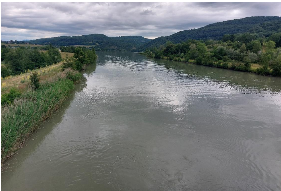
Figure 12. Canal d'amenée en aval pont Cressin-Rochefort – Entrée du Lit-au-Roi. CNR 2024
