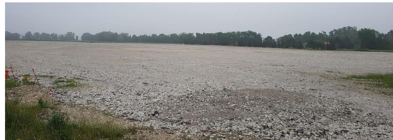
Photo 18. Zone industrielle dans la partie est du secteur d'étude dans laquelle des bâtiments ont été démolis récemment
