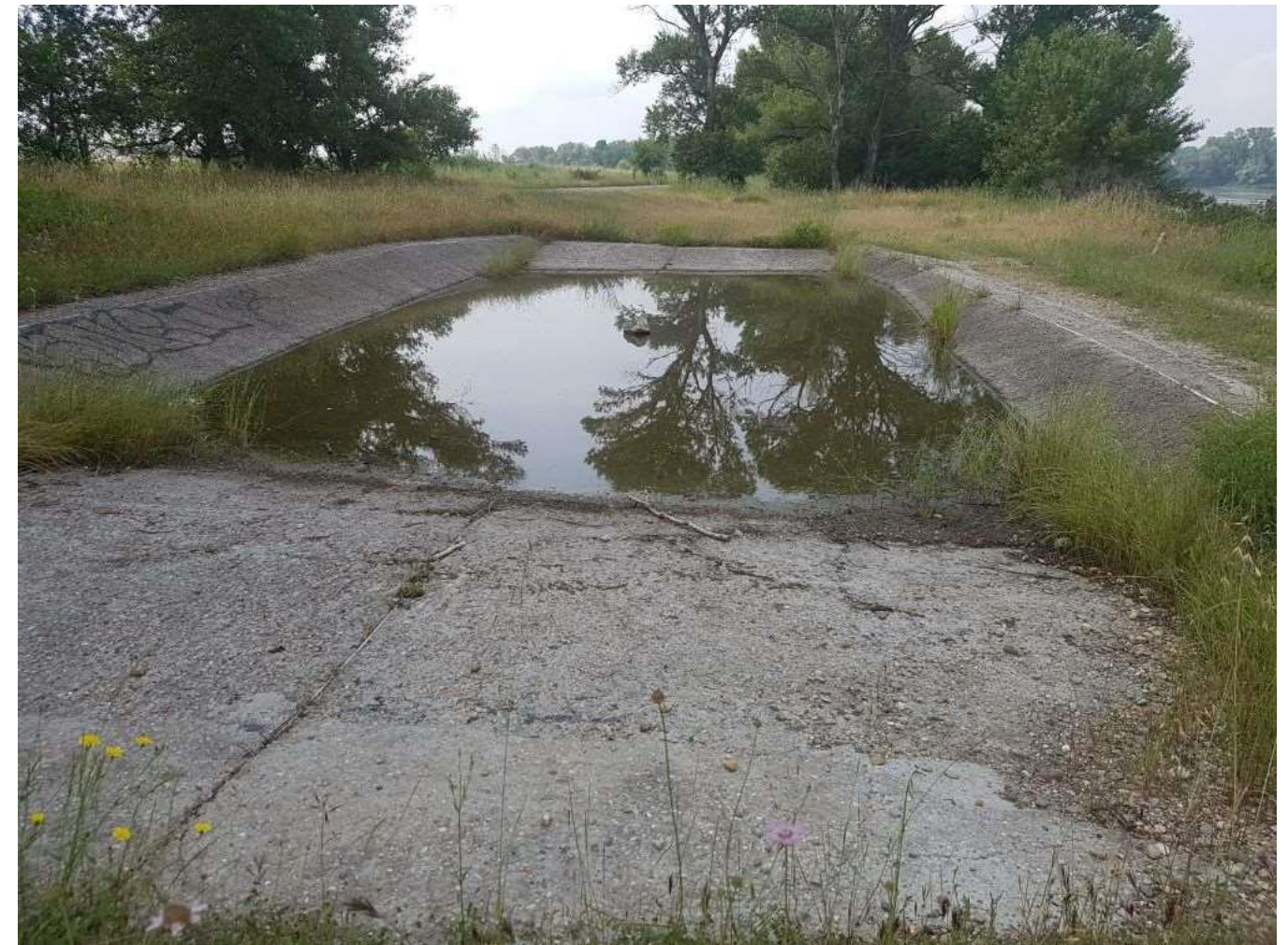
Photo 10. Bassin de stockage des eaux à surface complètement artificielle dans la partie nord-ouest en limite du secteur d'étude
