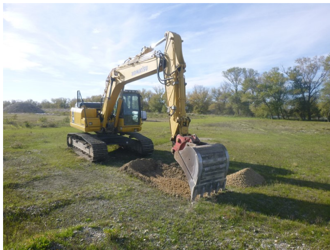
Figure 22 : Pelle mécanique utilisée pour la réalisation des fouilles
