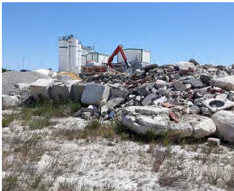
Figure 10 : Dépôt de déchets de démolition sur le site de LAFARGE en limite de site le 6 mai 2019 (CISMA Environnement)
