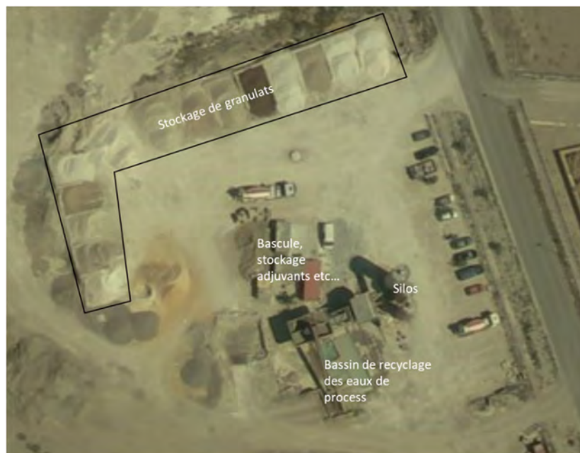
2012 – Centrale à béton SYLVESTRE
