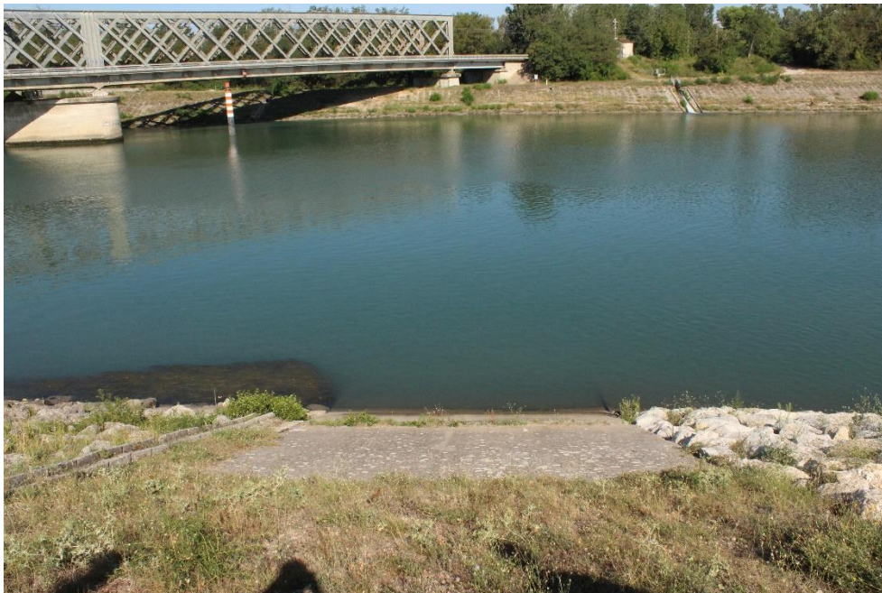
Figure 8. Vue de la berge en rive gauche du canal de fuite au site de restitution PK 195.200 - (ACME -2023)
