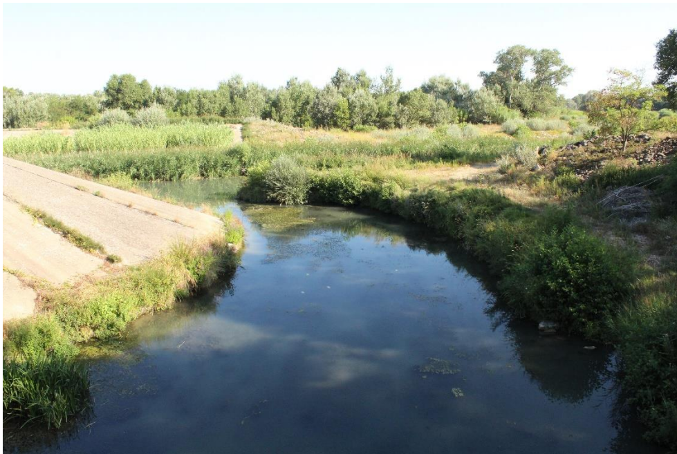
Figure 6. Vue de l'amont des vannes du Lez - (ACME - 2023)
