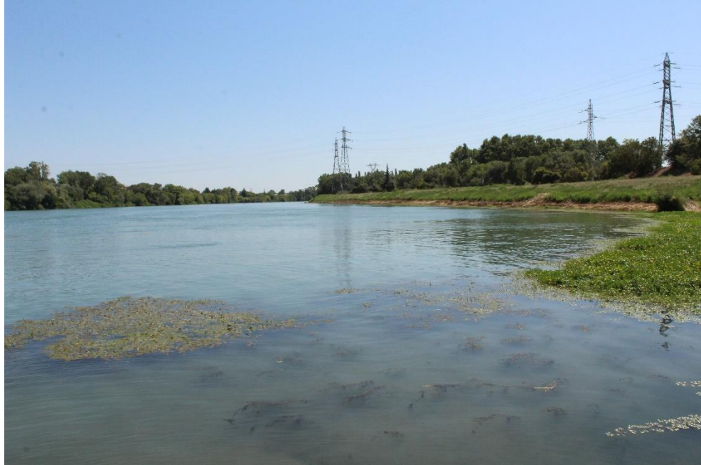
Figure 8. Vue vers l'aval du bassin de virement du Pontet (ACME, 2023).
