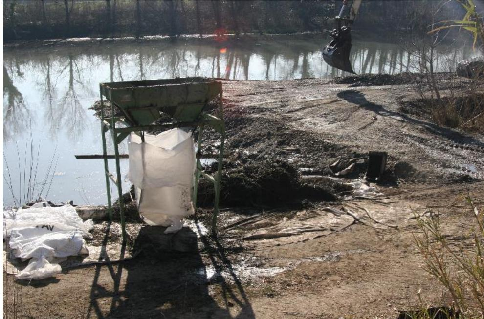
Figure 4. Trémie type pour la mise en big-bag des fragments de jussie à l'aide d'une trémie (CNR, 2015)
