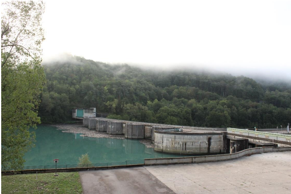
Figure 7. Vue sur la zone d'intervention en amont du barrage-usine de Génissiat (ACME, 2022)
