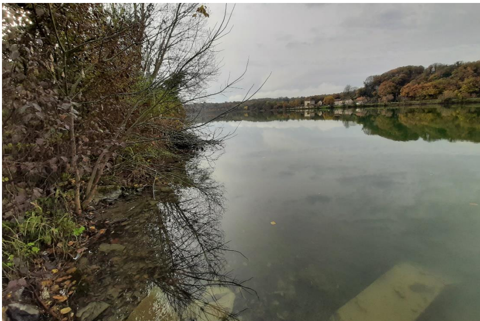
Figure 6. Vue vers l'amont de la berge au PR2 en rive droite de la retenue de Sault-Brénaz (CNR -2022)
