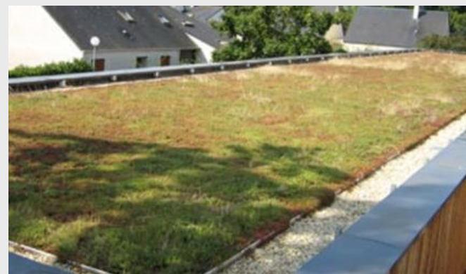
Exemple de toiture végétalisée
