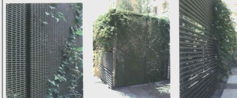
Illustration de locaux techniques
