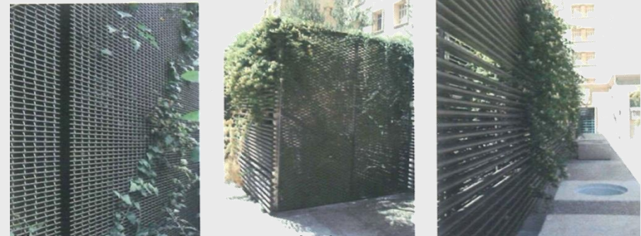
Illustration de locaux techniques
