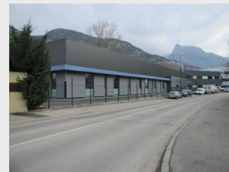
Exemple de bâtiment aux façades à tonalité grises. Le bandeau bleu constitue un repère colorimétrique de l'entreprise.
