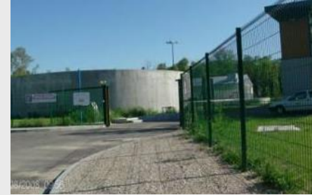
Exemple d'accès en retrait (Portail d'accès à la STEP de St Vallier) : Le portail et la clôture sont traités avec les mêmes matériaux de couleurs identiques
