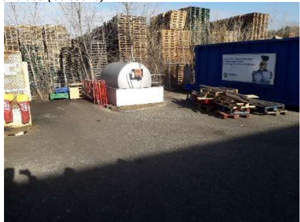
Cuve aérienne de GNR
