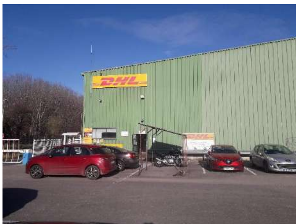
Entrée du site
