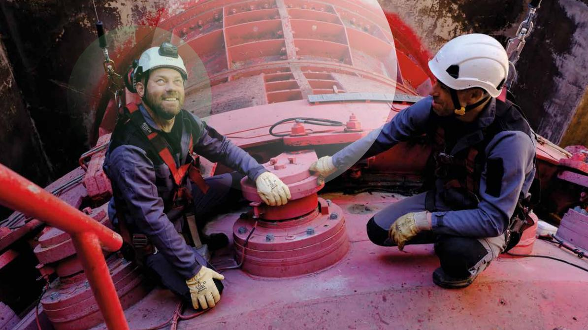
Innov'Action CNR : poutre d'assujettissement et filin de sécurité pour opération de maintenance
