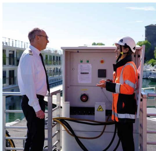
Borne haute tension pour l'alimentation électrique des bateaux à passagers de Tournon-sur-Rhône (07)
