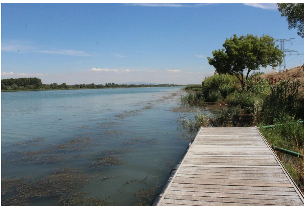
Figure 10. Vue vers l'amont depuis la rampe à bateau de Barbantane (ACME, 2022)
