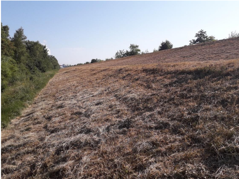
Figure 8. Vue sur la zone de ressuyage pour le dragage de l'exutoire du ruisseau des Lavandières (ARTELIA, 2022)
