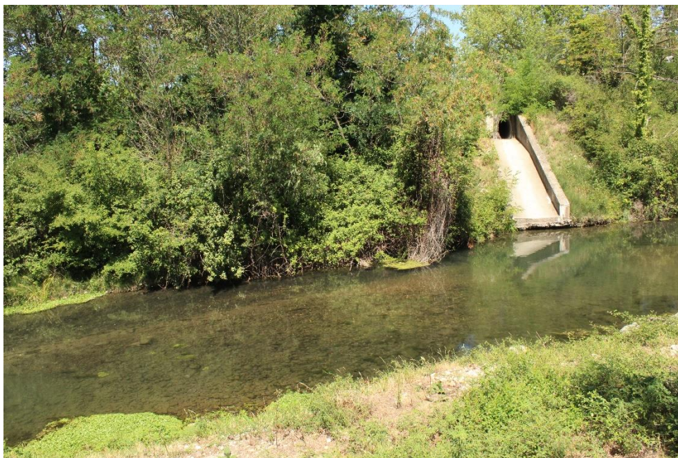
Figure 6. Vue sur le contre-canal rive droite au PK 119.000 depuis l'aval (ACME, 2022)
