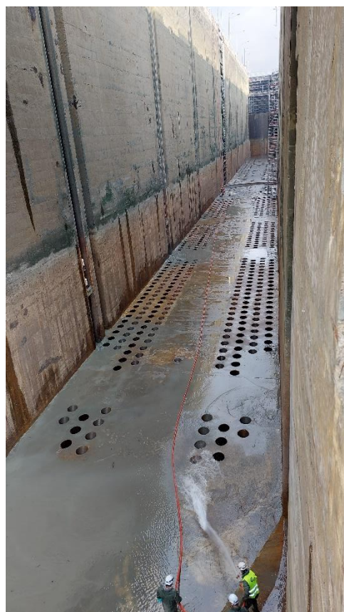
Opération d'entretien de l'écluse de Bollène Arrêt annuel de navigation 2022
