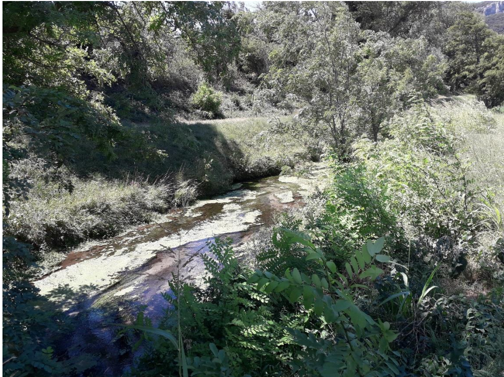
Figure 10. Vue sur la zone de dragage en aval de l'ouvrage PK 169.560 (ARTELIA, 2022)
