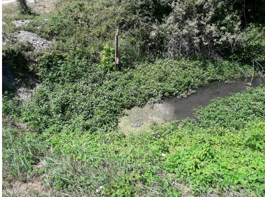
Figure 6. Vue sur la zone de dragage en amont de l'ouvrage PK 167.350 (ARTELIA, 2022)
