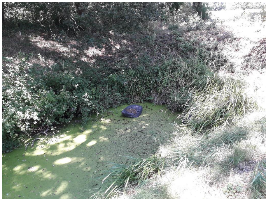
Figure 7. Vue sur l'aval de l'ouvrage PK 169.200 (ARTELIA, 2022)
