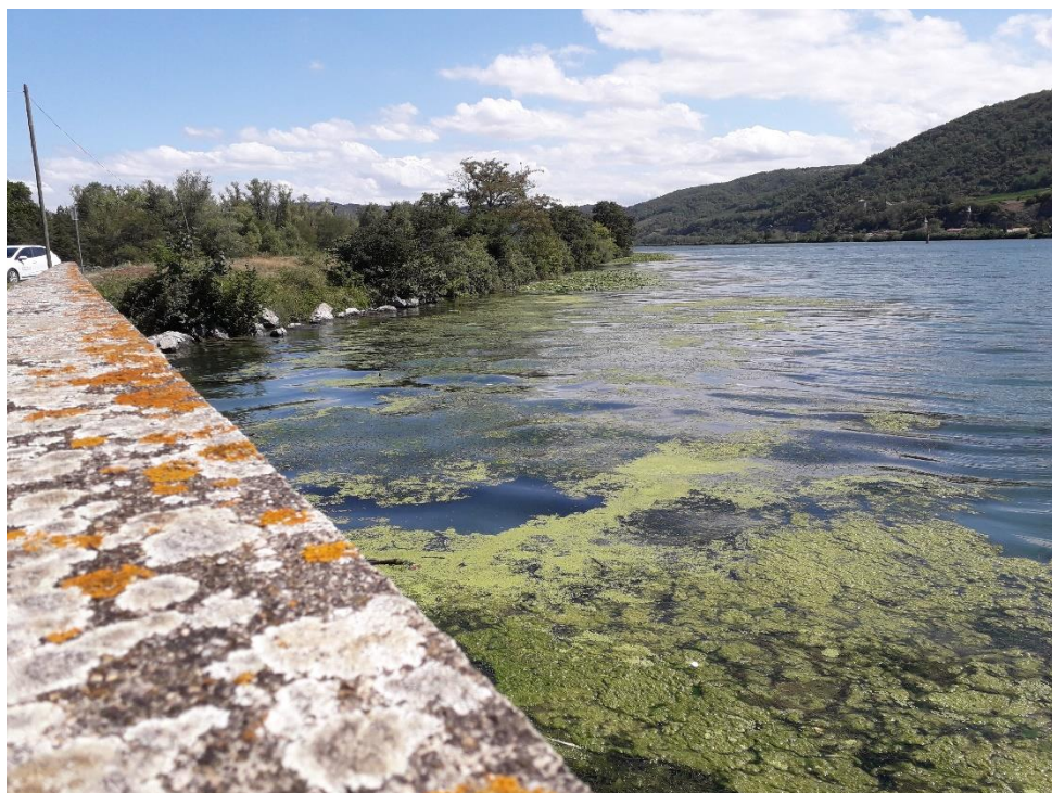
Figure 8. Vue du Rhône en rive droite en amont du barrage (ARTELIA, 2022)
