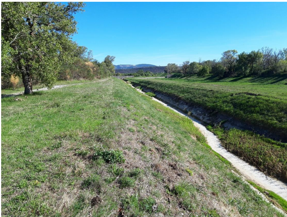
Figure 6. Vue du fossé de la Berre depuis l'aval (CNR, 2022).
