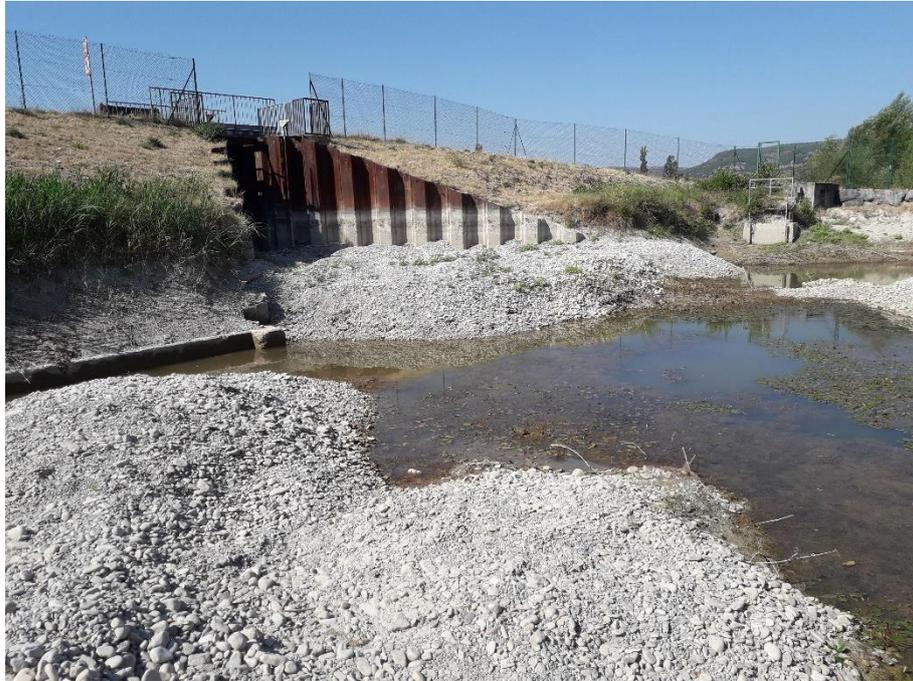
Figure 8. Vue sur le bassin de dégravement de la passe à poissons (ARTELIA, 2022)
