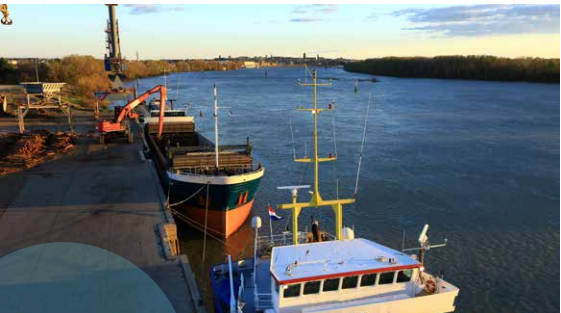
Sur le site industriel et portuaire d'Arles, les bassins de virement ont été modifiés et le quai nord agrandi pour créer un troisième quai en eau profonde. La cale a été étendue et mise aux normes pour accueillir en réparation des unités de 135 mètres et 2200 tonnes.
