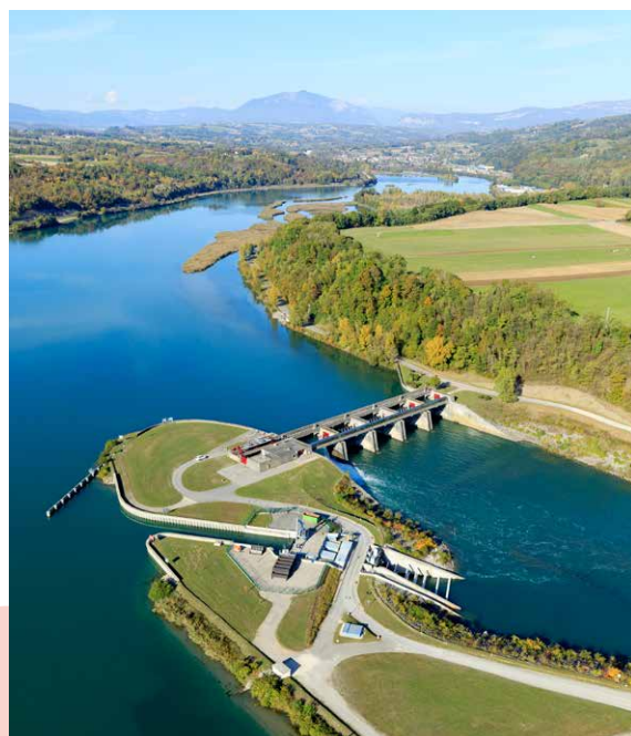
Barrage de retenue de Chautagne et PCH sur Le Rhône (73)
