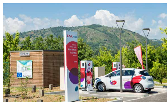
Bornes de recharge électrique à Laveyron (Drôme)
