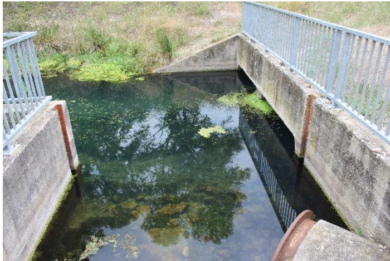
Figure 13. Vue de la tête amont de l'aqueduc OH200 (ACME,2018)
