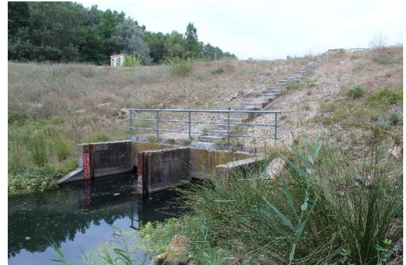
Figure 14. Vue de la tête aval de l'aqueduc OH200 (ACME,2018)
