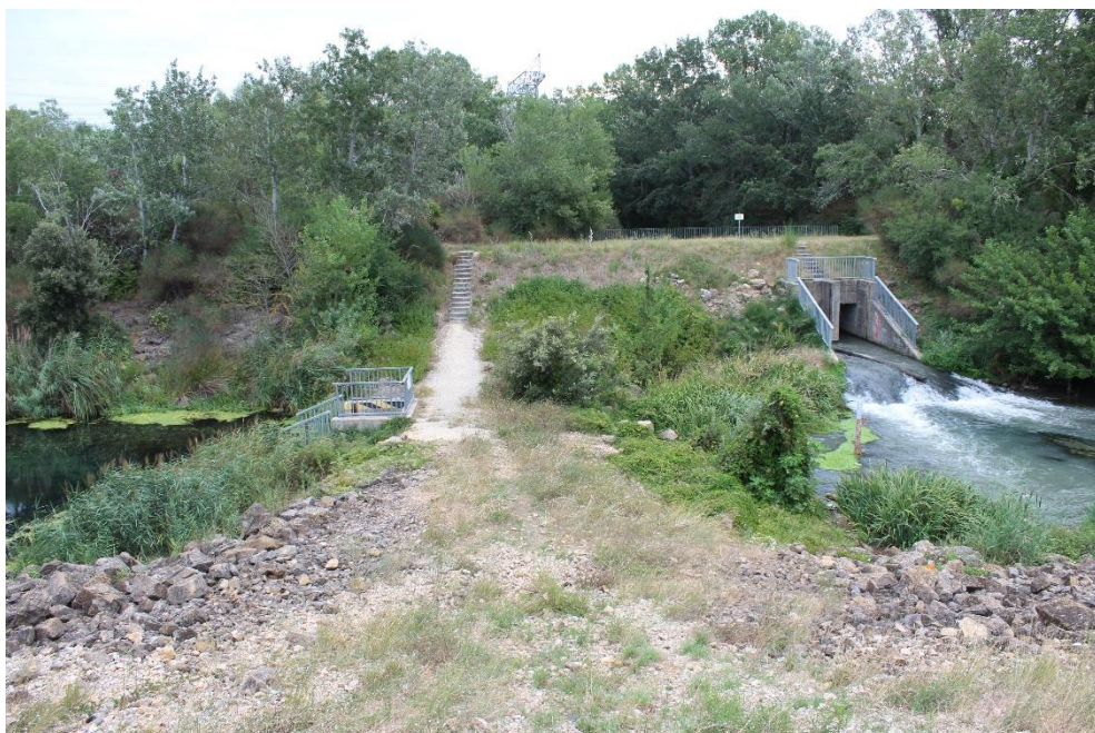
Figure 15. Vue de l'ouvrage OH 204 avec restitution du Lez en aval (ACME,2018)
