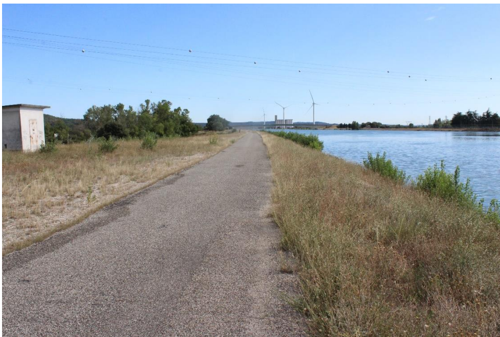
Figure 7. Berges rive gauche du canal d'amenée au PK 184.400 (ACME – 2020)
