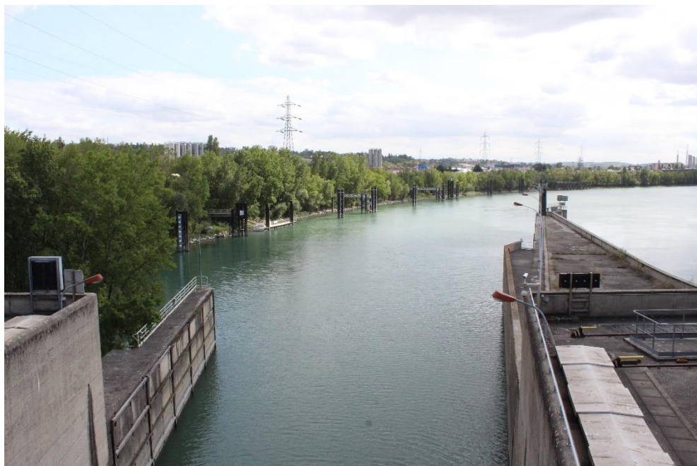
Figure 13. Vue sur le garage aval de l'écluse de Pierre-Bénite (ACME 2019)
