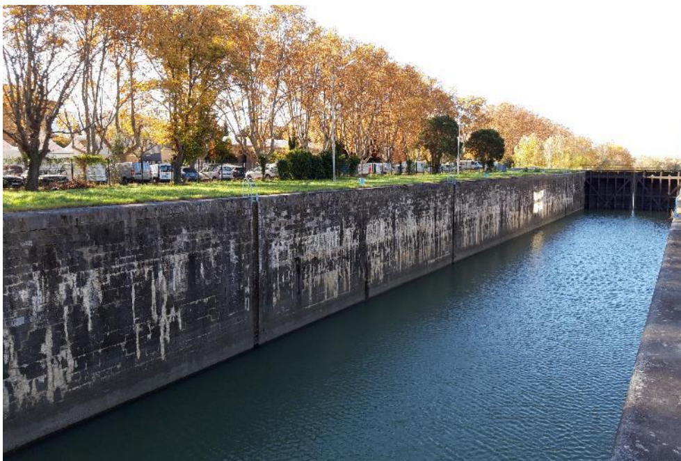
Figure 9. Vue vers l'aval du sas de l'écluse d'Arles (CNR 2021)
