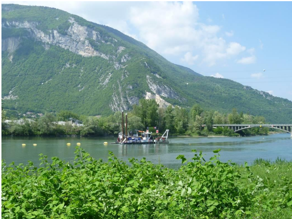
Figure 9. Dragage du chenal navigable en aval du pont de la Loi (CNR -2010).
