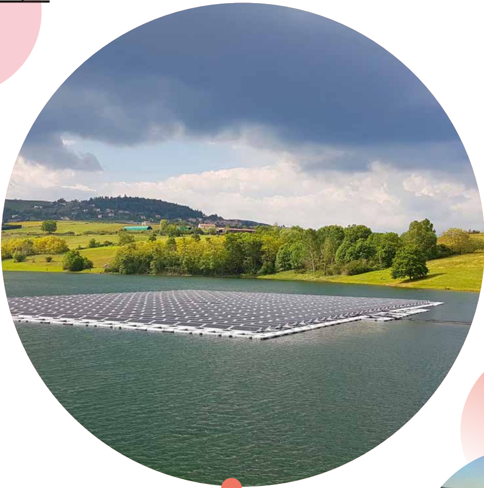
Parc photovoltaïque flottant sur le lac de La Madone à Mornant (69)
