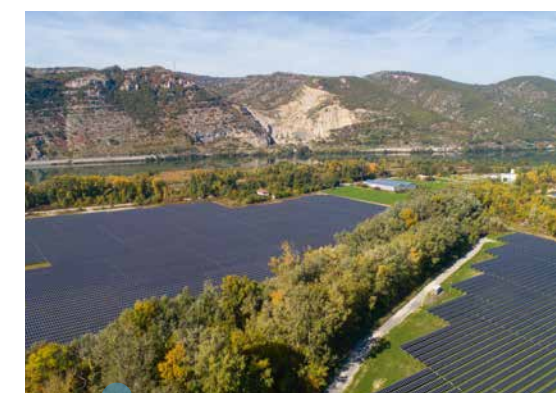
Parc photovoltaïque Le Pouzin 2
