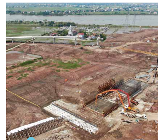
Au Vietnam, après plusieurs années d'études, CNR supervise en association avec Egis et son partenaire vietnamien VIPO les travaux de construction d'un canal de jonction entre deux bras du fleuve Rouge, équipé d'une écluse à grand gabarit et d'un viaduc routier.
