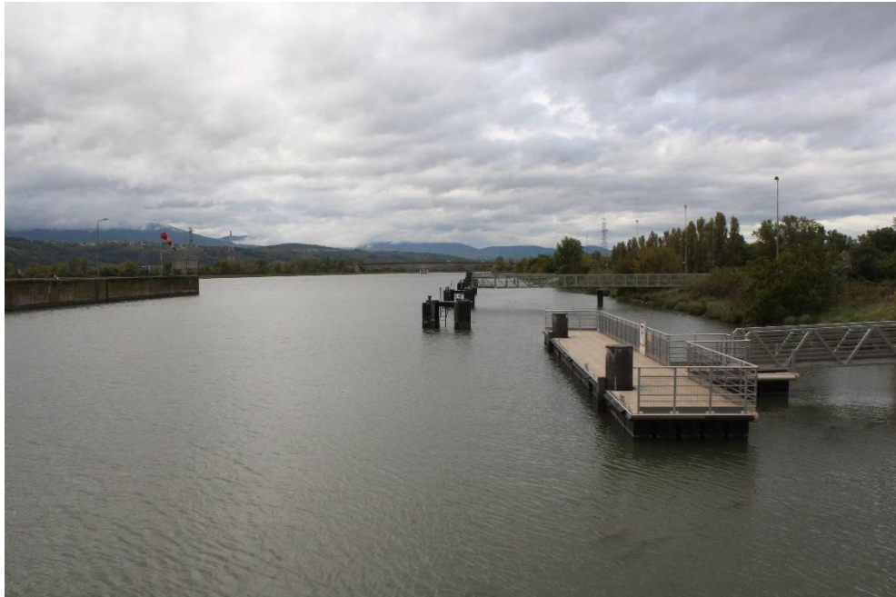
Figure 8. Le garage amont de l'écluse de Péage-de-Roussillon (ACME 2021)
