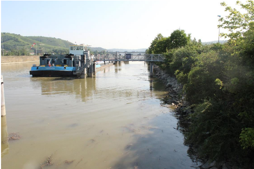
Figure 6. Accès canoés du garage amont de l'écluse de Vaugris (ACME 2021)
