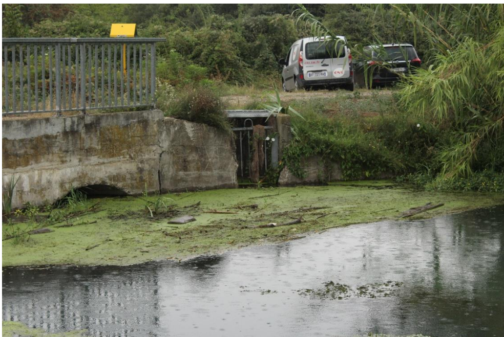
Figure 7. Vue de la tête amont de la prise d'eau du petit Béal en rive droite du contre-canal - (ACME - 2021)
