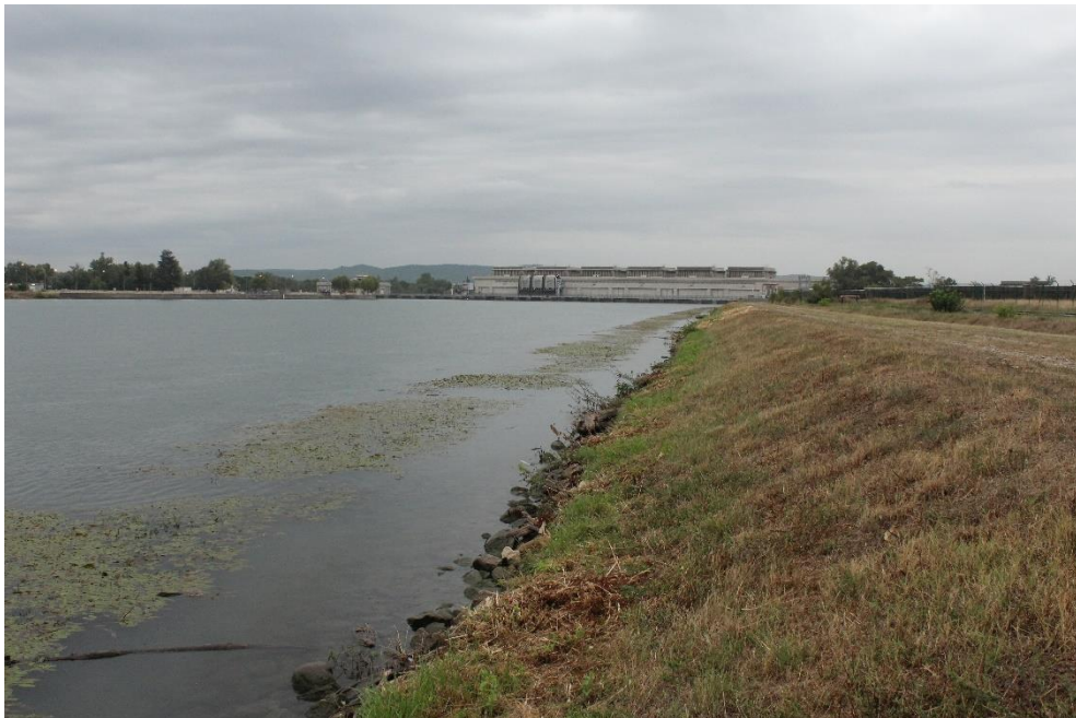
Figure 9. Vue de la berge en rive droite du canal d'amenée en amont de l'usine - (ACME -2021)
