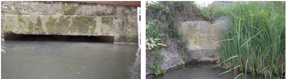
Figure 7. Vue de la tête amont (photo de gauche) et de la tête aval (photo de droite) de la buse de l'accès Banastier (SATIF -2020)
