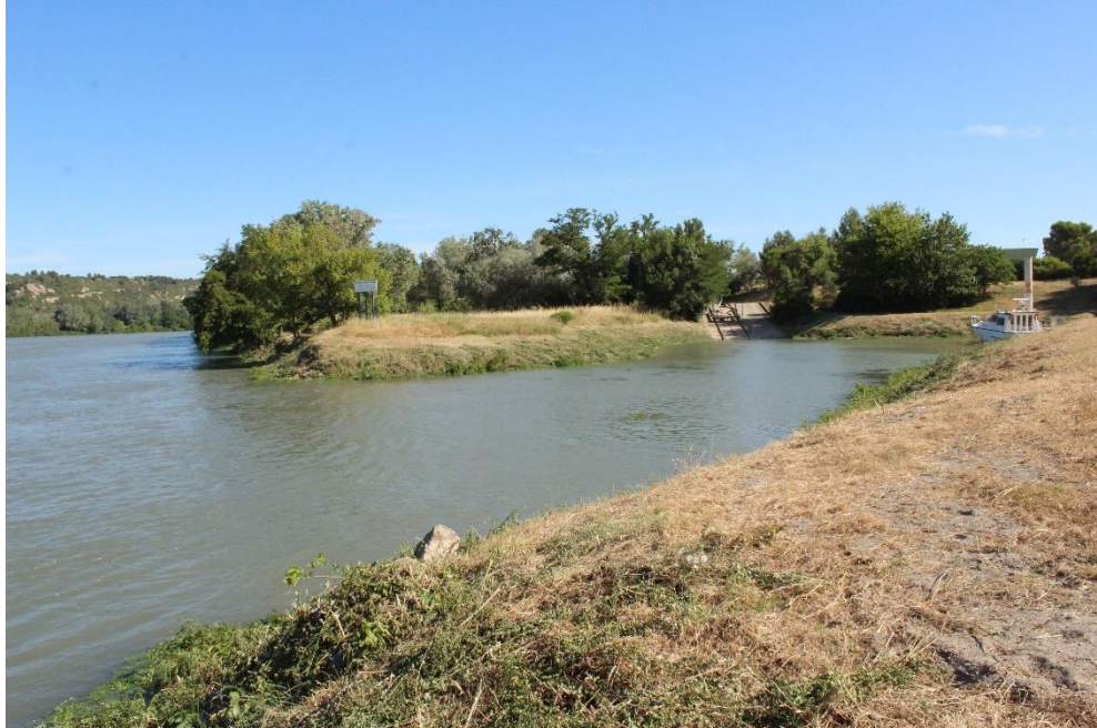
Figure 8. Vue de la passe d'accès du port vedette CNR (ACME - 2021)
