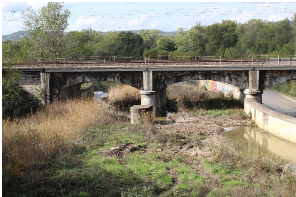
Figure 10. Vue vers l'aval des atterrissements du piège à graviers de la Riaille depuis le pont de la RD 73 (ACME 2019)
