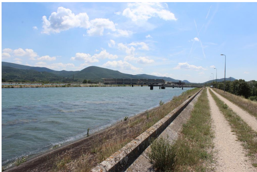
Figure 12. Vue du garage amont de l'écluse de Logis-Neuf depuis l'amont (ACME, 2017)
