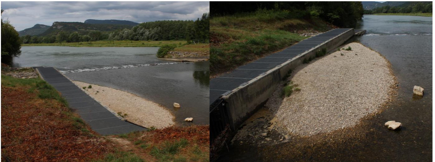
Figure 11 : photos de la zone travaux (ACME, 2016)
