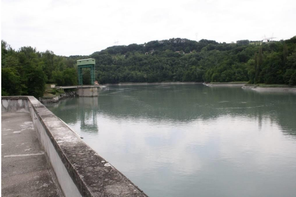
Figure 7. Vue de la tour de la vidange de fond depuis la plateforme rive droite (ACME – 2013)
