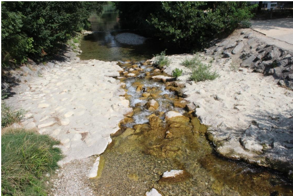
Figure 2. Aménagement piscicole du seuil du Flon – ACME 2019
