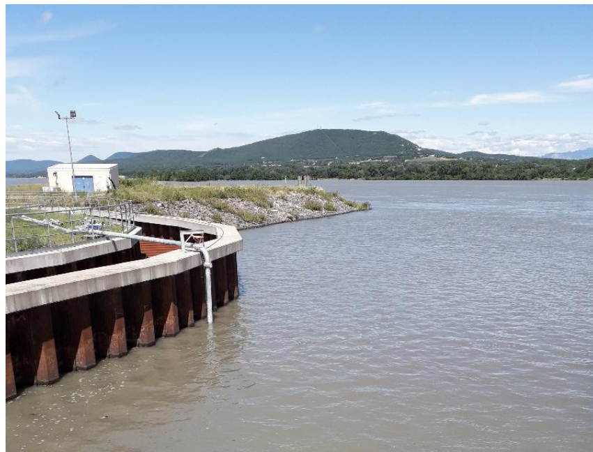
Figure 6. Vue de la zone dragage depuis l'aval (ARTELIA, 2021)
