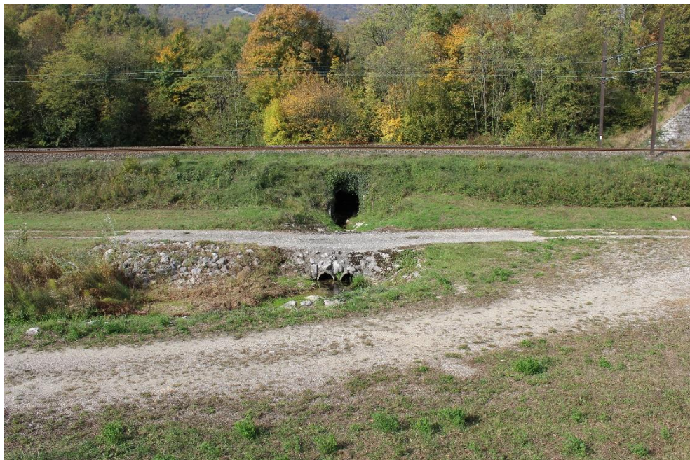
Figure 5. Vue générale des buses du Rhémoz et des pistes d'exploitation (ACME, 2020)
