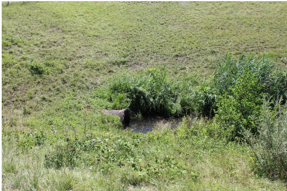
Figure 5. Vue de la tête amont de la buse depuis la rive gauche - (ACME -2021)
