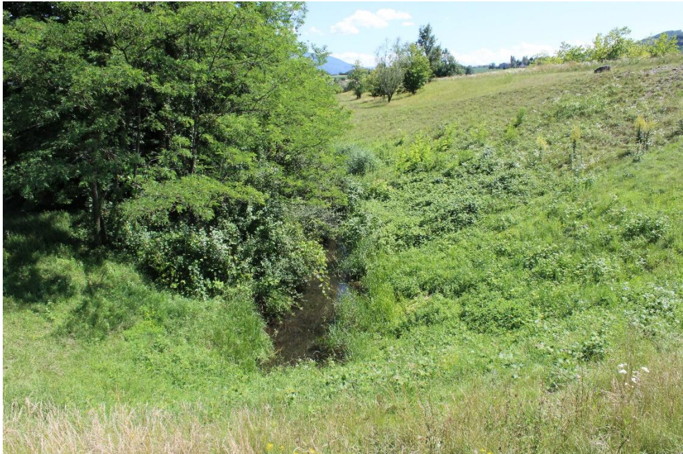
Figure 6. Vue du contre-canal en aval de la buse depuis la voie d'accès à la base de loisirs d'Ecoinçon - (ACME -2021)
